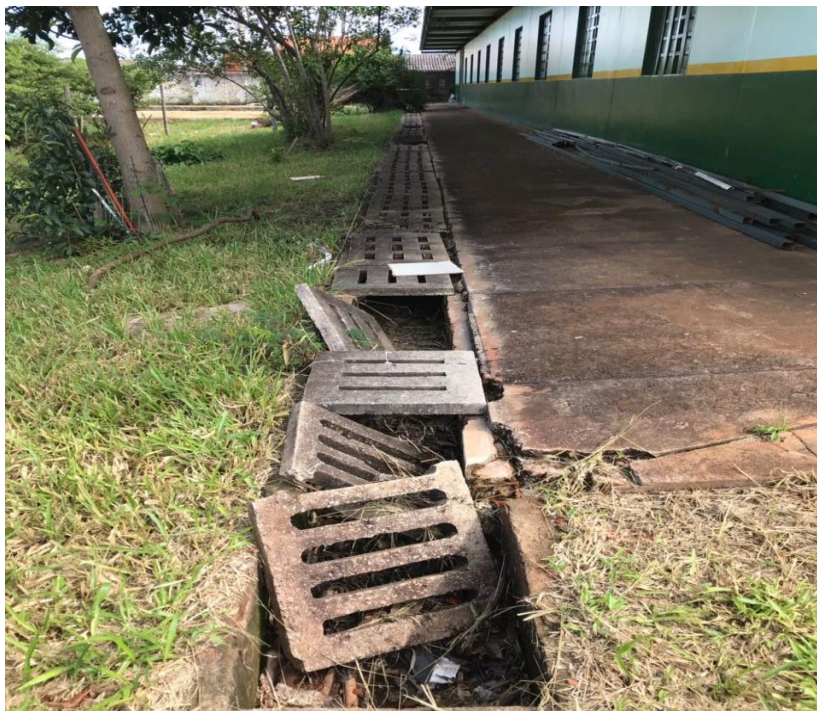
FOTO 04: Calhas quebradas na lateral da escola.
