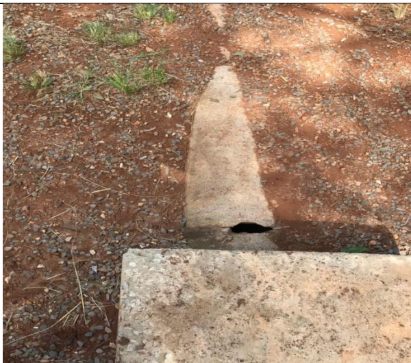
FOTO 05: Manilha necessita ser trocada, pois se encontra quebrada na frente da quadra poliesportiva. Fonte: Débora Ribeiro. Data: Fevereiro/2018
