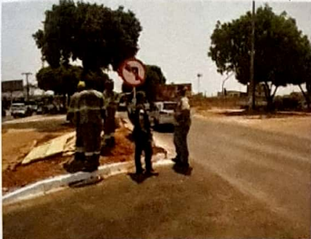
Obra de implantação do cruzamento semafórico entre as vias "NM3" / "O4"
