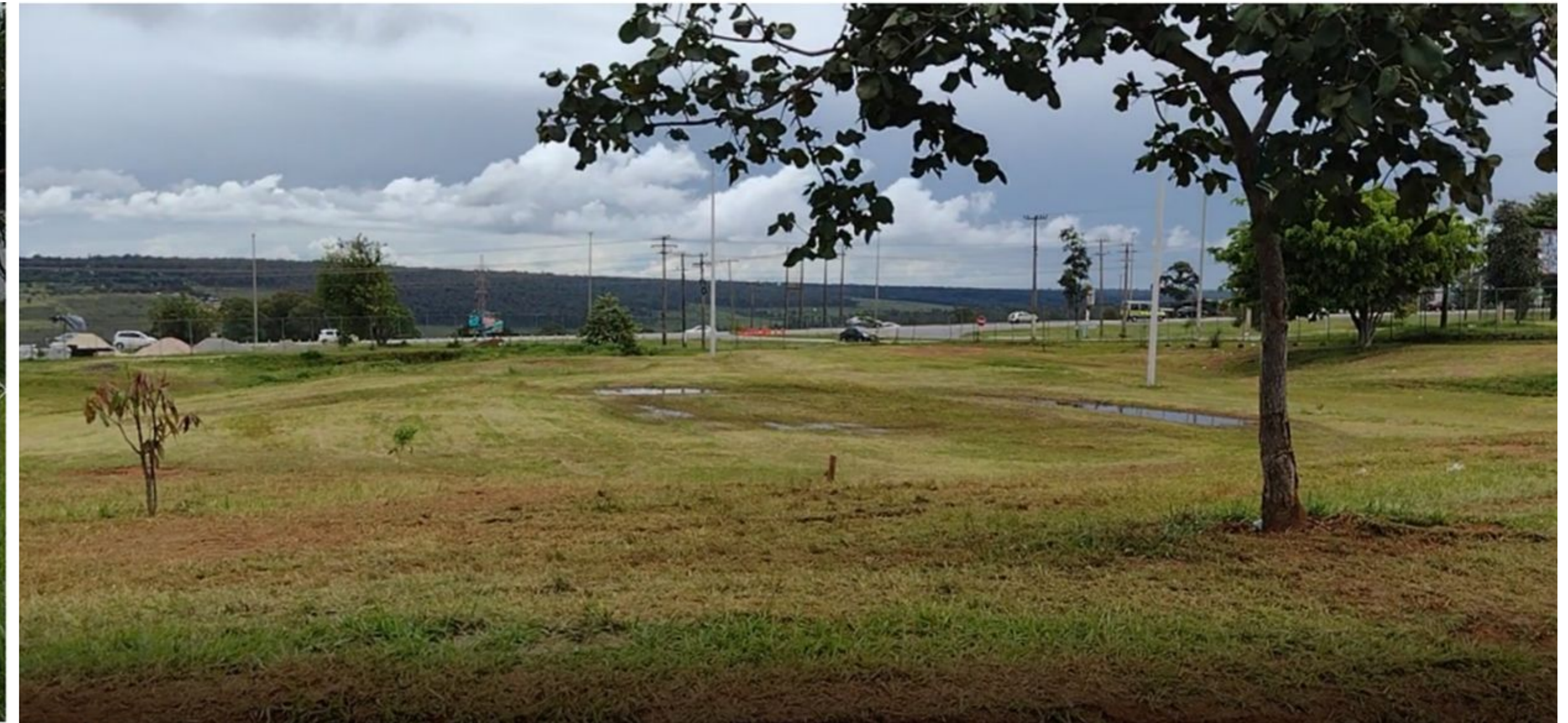
FIGURA 06: Bacia de retenção na área do lote AE 1 da QNO 6. Fonte: DIEPO 03/2022/SEDUH
