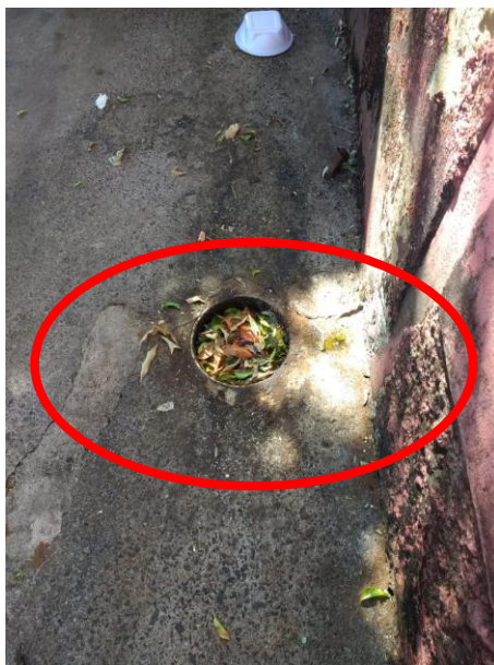
FOTO 04: As caixas de gordura atuais, não comportam mais a necessidade que as bancas tem exigido. Fonte: Thays Alaor/Colom – RA-IX Data: Setembro/2018
