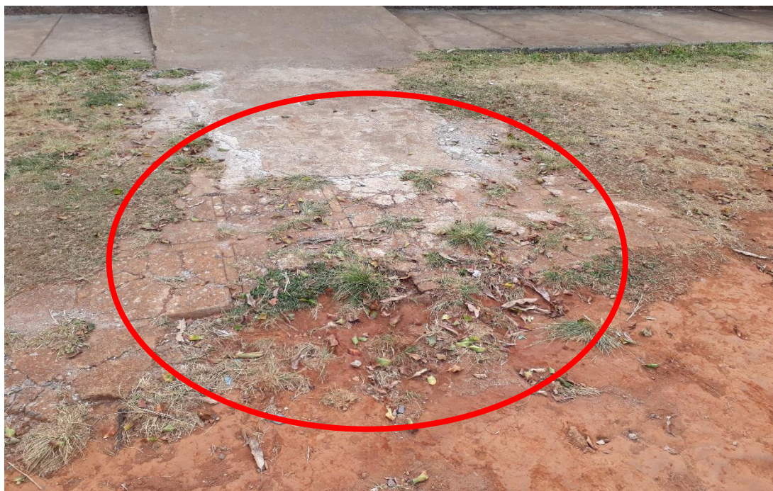
FOTO 02: Calçamento de ligação do terreno à entrada da igreja em estado de degradação.
