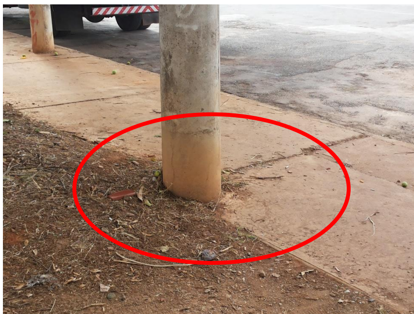
FOTO 09: Presença de poste de iluminação na faixa de circulação à esquerda da edificação. Fonte: Dos autores Data: Outubro/2017
