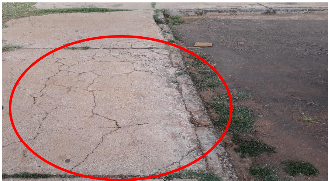
FOTO 01: Recuos da calçada à lateral direita da igreja com trincas e rachaduras.
