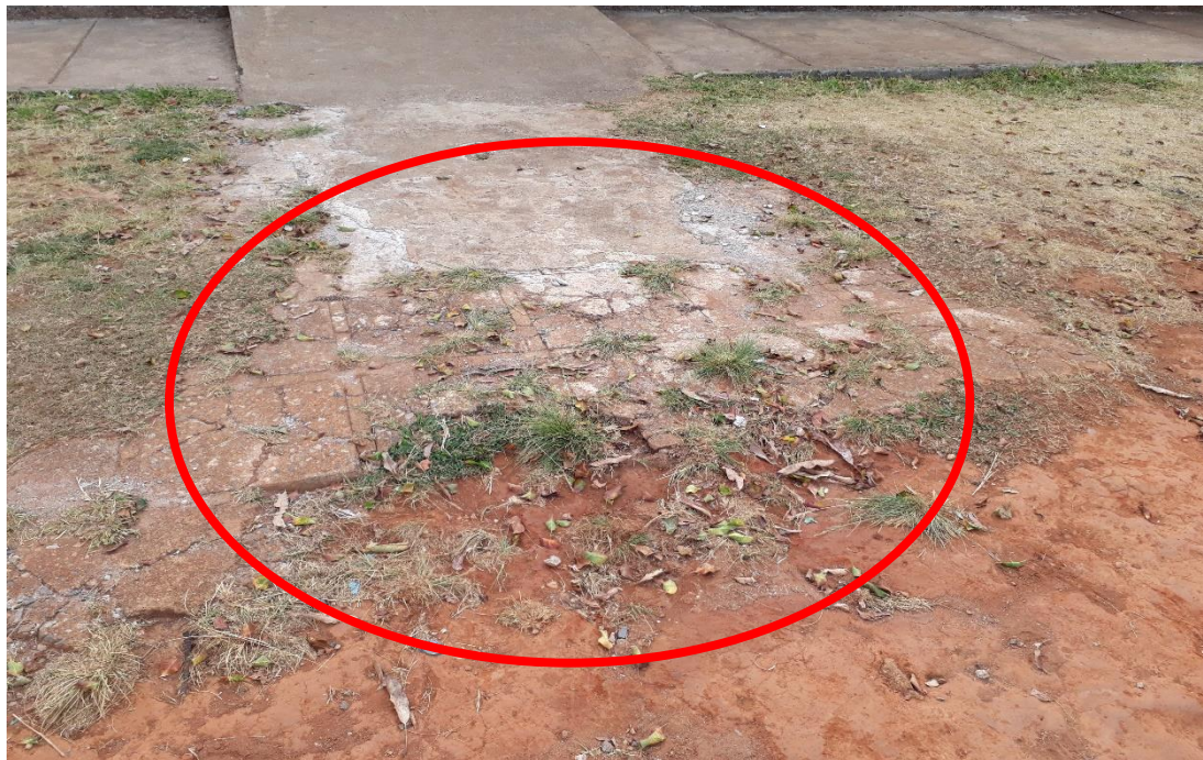
FOTO 02: Calçamento de ligação do terreno à entrada da igreja em estado de degradação. Fonte: Dos autores Data: Outubro/2017
