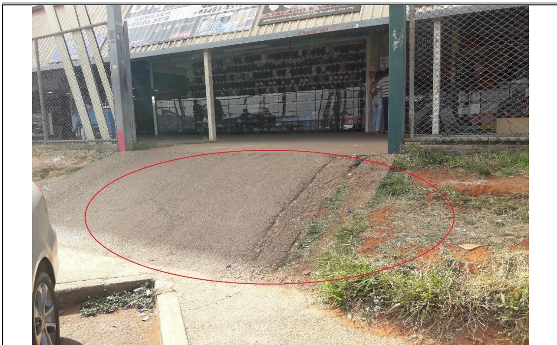
Fonte: Do autor, data: 10/2017 Rampa não atende a NBR 9050 de acessibilidade.
