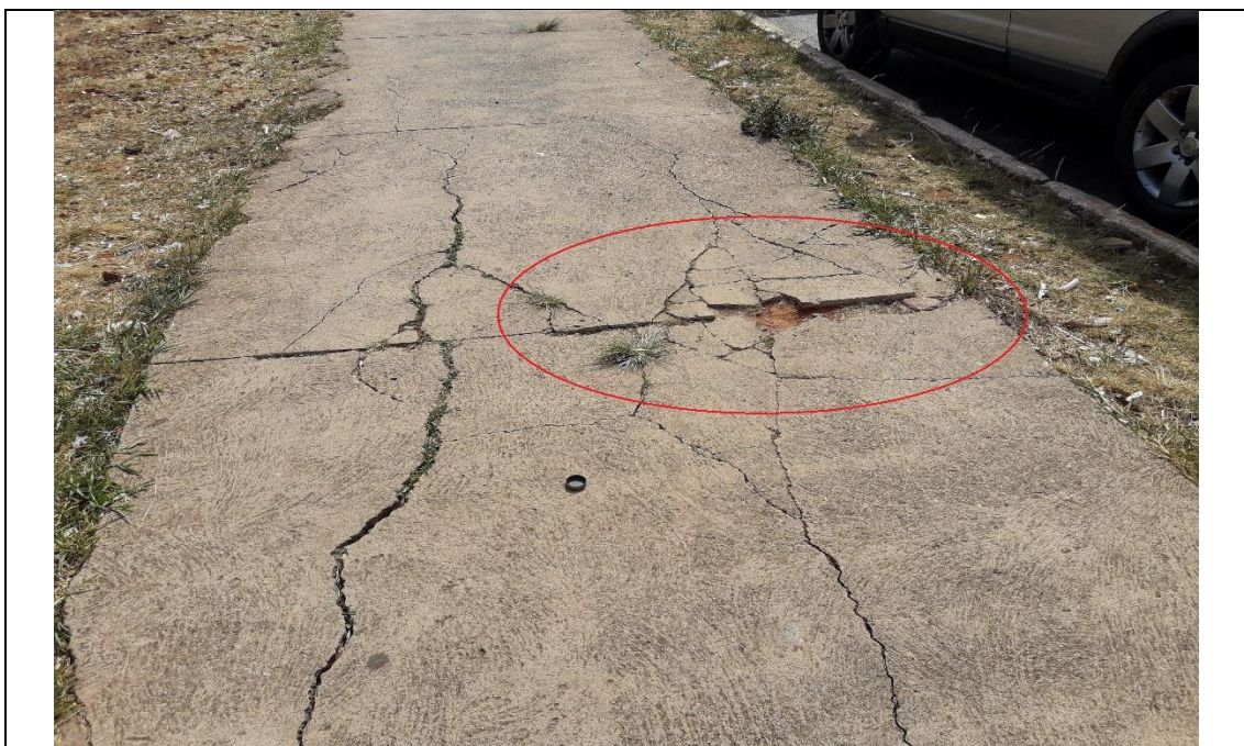
Fonte: Do autor, data: 07/2017 Calçadas degradadas, com fissuras e irregularidades, que prejudicam a acessibilidade.
